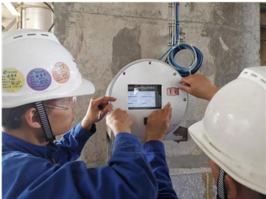
在线分析仪表在化工行业的应用已经十分的广，为化工生产过程控制、提高产品质量、指导操作提供了重要手段和依据在线分析仪表在生产现场连续自动分析各种混合气体样品的成分含量及单个组分含量，使得工艺控制更适时、更准确，实现了生产比较好化和效益比较大化。但在实际生产过程中，有很多的在线分析仪表不能正常可靠持续的投入运行，不能真正的发挥其作用，其主要原因就是工艺现场对在线分析仪表运行条件认识不足，样品预处理不能使测量样气达到分析仪的要求，从而制约了在线分析仪表的使用和发展。气体在线分析仪预处理系统：、非腐蚀的样品，在正常情况下，样品必是在限定的温度、压力和流量范围之内，样品处理的基本任务和功能归纳：流量调节，包括快速流路和分析回路：压力调节，包括降压、抽吸和稳压；温度调节，包括降温和保温；除尘，除水除湿和气液分离，去除有害物，包括对分析仪有危害的组分和影响测量的扰组分。驰光具备雄厚的实力和丰富的实践经验。江西次氯酸根浓度在线分析仪表生产商
